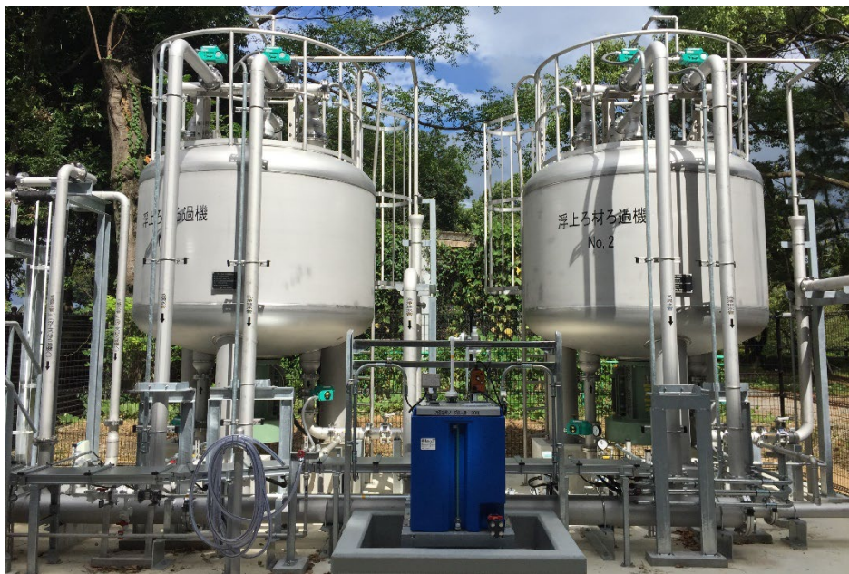
写真：水族館・動物園等に用いられる水処理装置 浮上ろ過装置「FM フィルタ」
